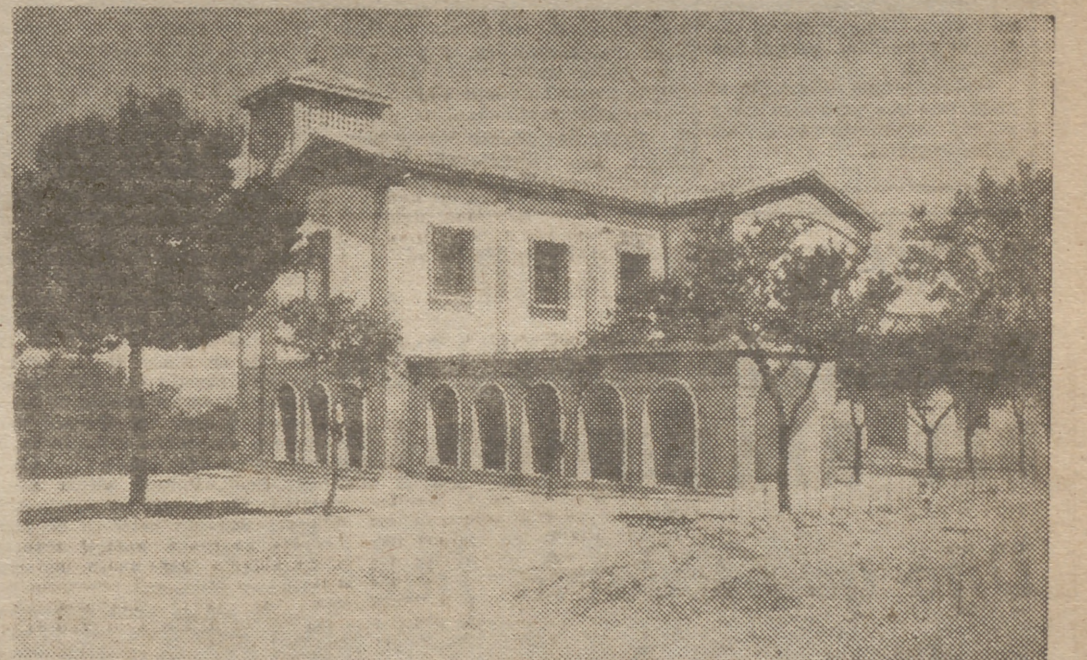
EXTERIOR DE LA IGLESIA
