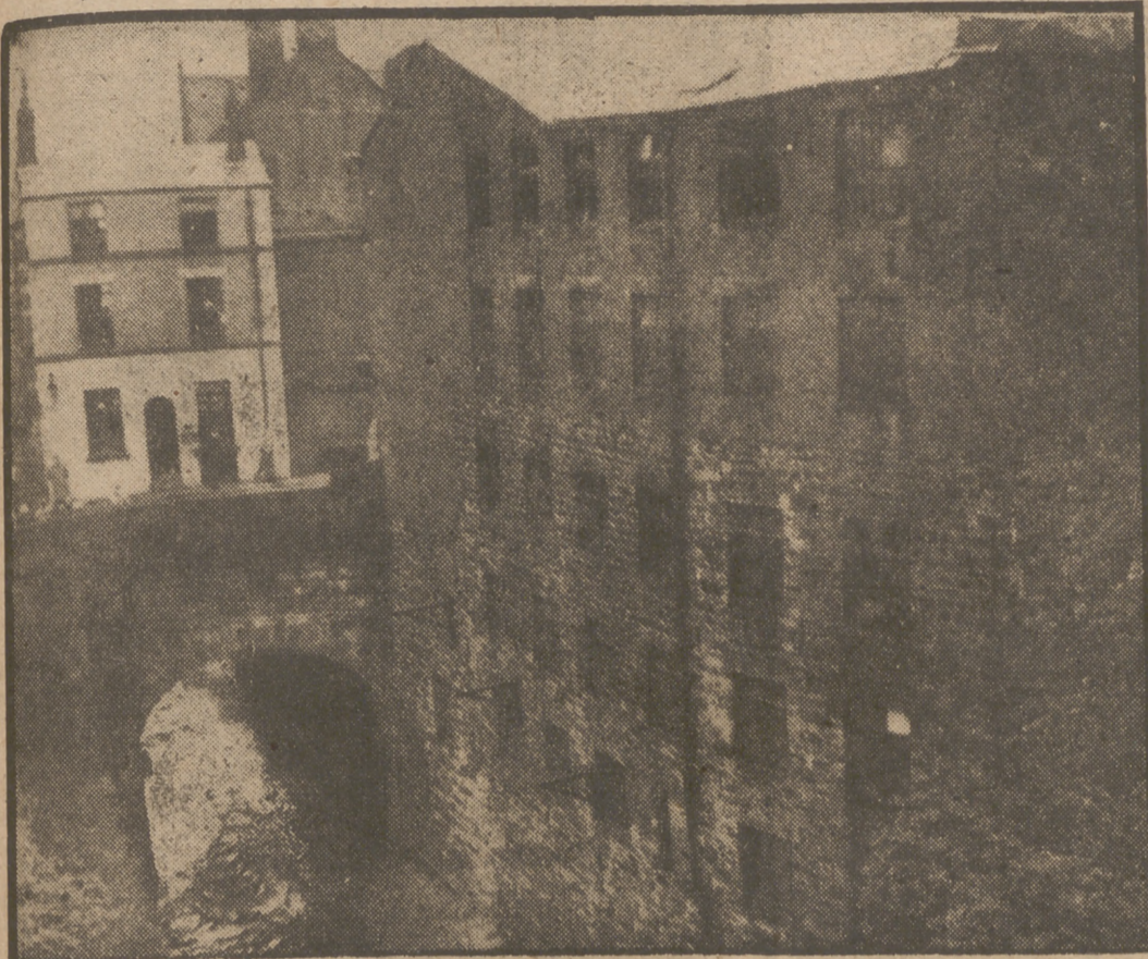
La fachada posterior del edificio en que estaba el Club Storey, en el último piso, desde cuyas ventanas las jóvenes, con sus vestidos de baile incendiados, se arrojaron al vacío, yendo a caer en el río y resultando unas muertas y otras heridas de gravedad
