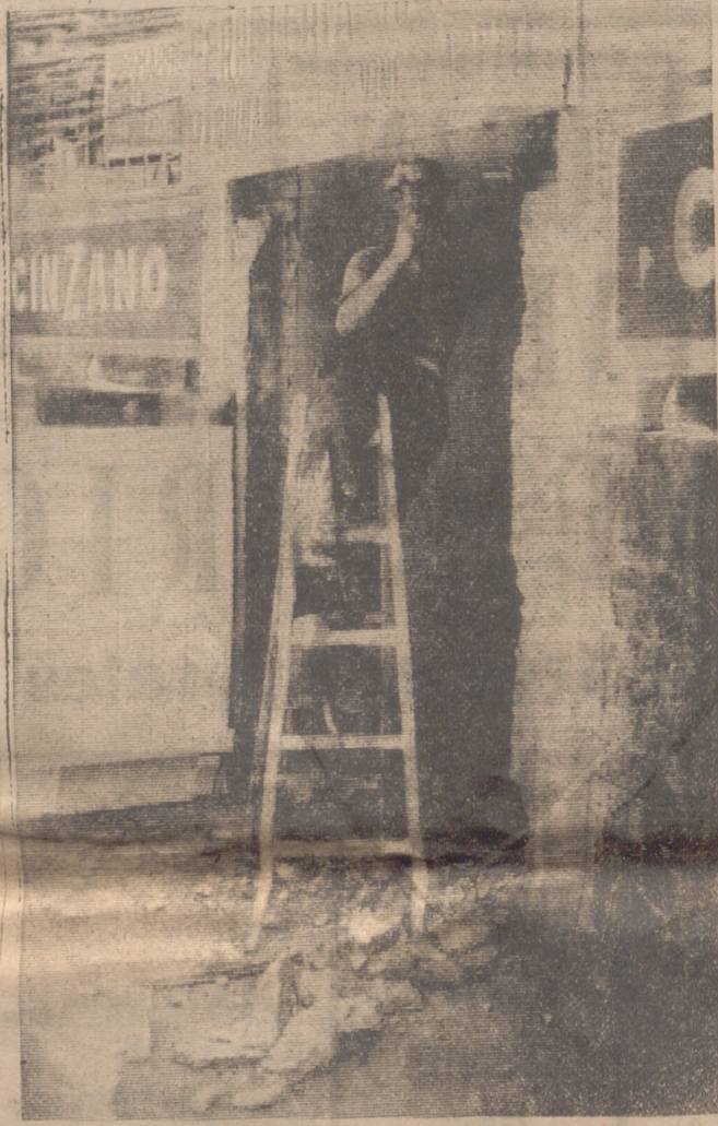
También la puerta de chi queros está siendo reparada. (Foto Albe)
