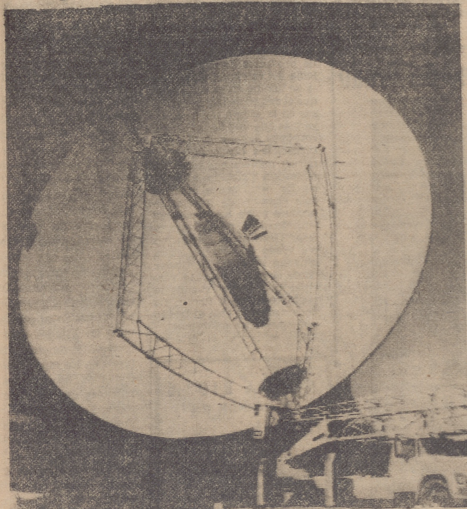
Esta antena parabólica gigantesca de 26 metros de diámetro y 250 toneladas de peso, recibirá las señales y las fotografías que transmita el «Lunar Orbiter» durante...
