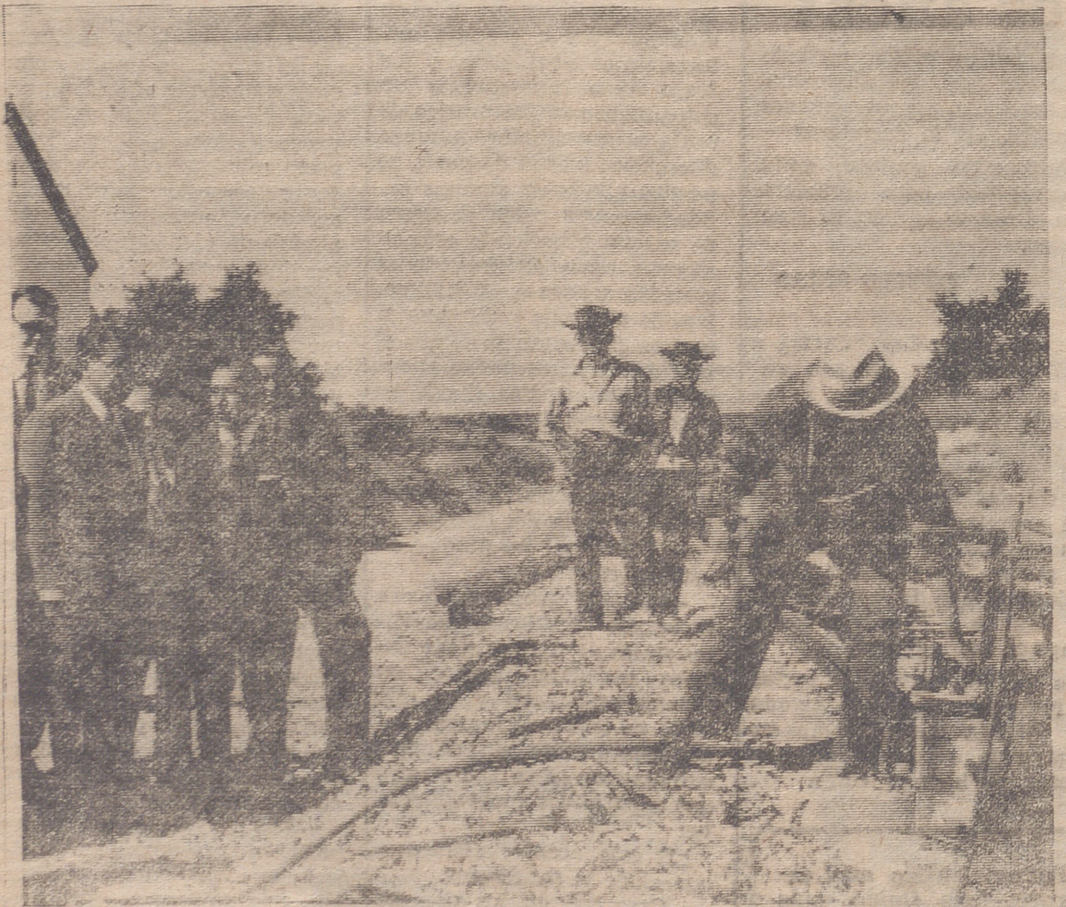
El ministro de Obras Públicas, don Federico Silva Muñoz, acompañado de altos funcionarios de su Departamento y de la «Renfe», realizó, en unión de los medios informativos de la capital de España, un recorrido por las obras de construcción del ferrocarril Madrid-Burgos...
