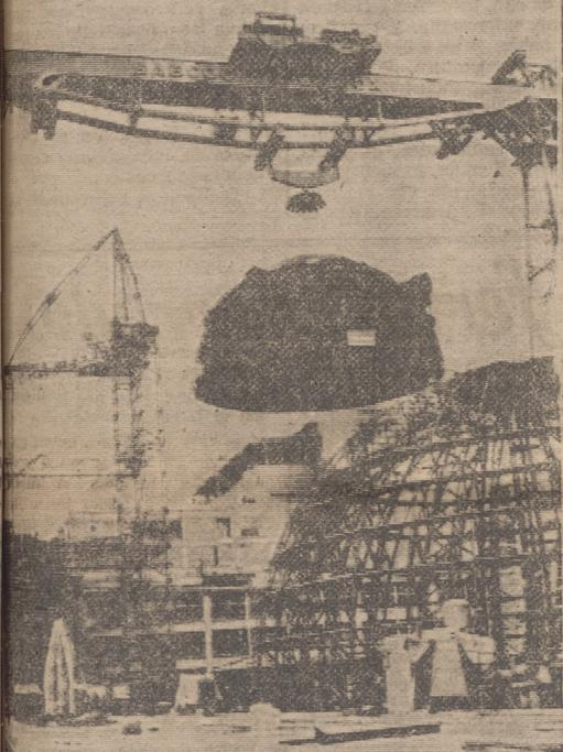
Una grúa "Goliat" transporta para su colocación la parte esférica superior (400 toneladas) del reactor número 1 de la estación nuclear Wylfam, en Angers (Inglaterra). Será, una vez terminada, la mayor estación nuclear del mundo y sus reactores están siendo construidos por la compañía inglesa Baccok & Wilcox. Producirá 1.180 megavatios y abastecerá al Noroeste del país en 1969. — (Foto "Fiel").
