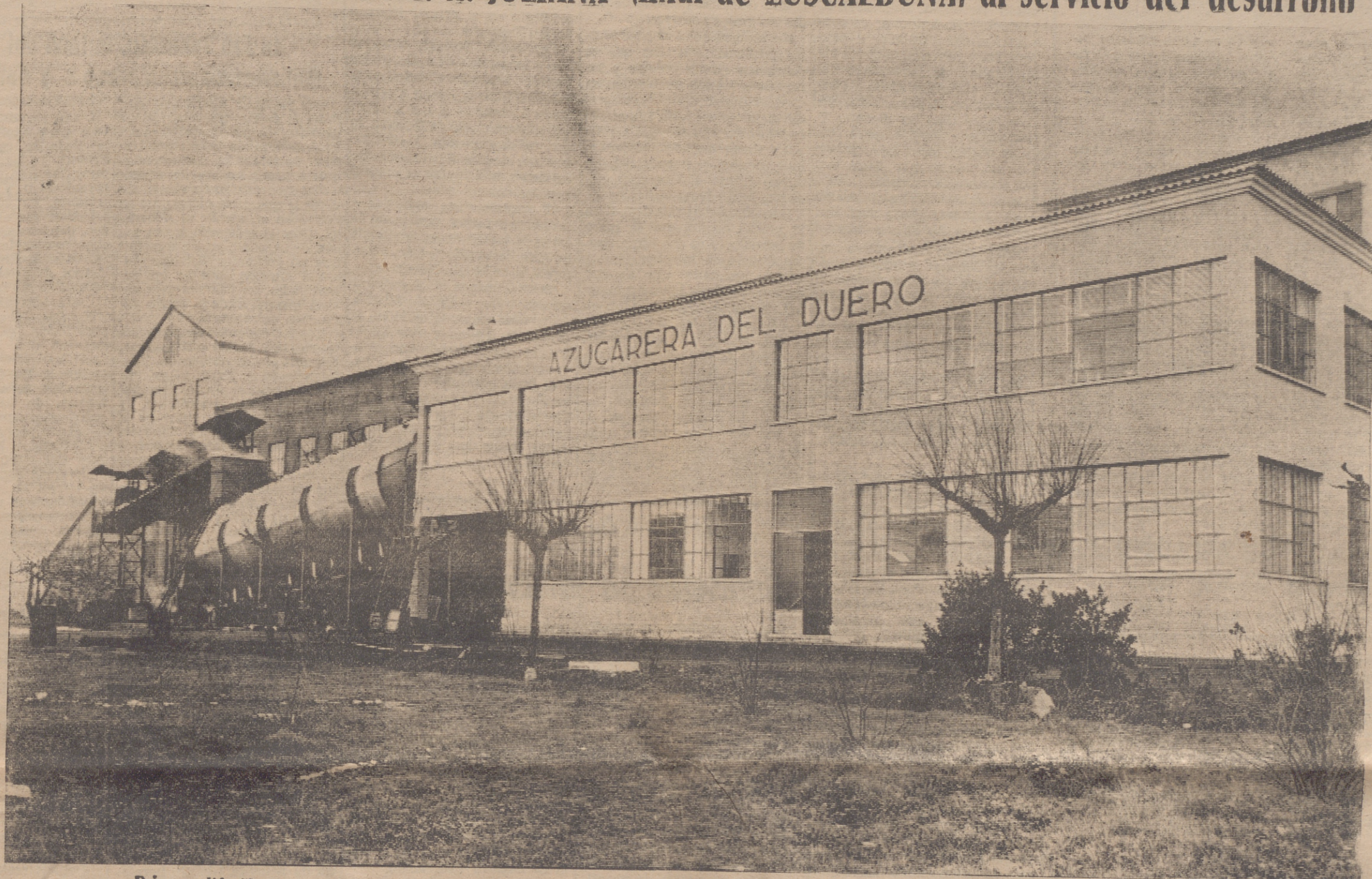
Primera difusión DDS instalada en España. Ha sido montada en el exterior de la factoría de EBRO Cía. de Azúcares y Alcoholes, en Toro
