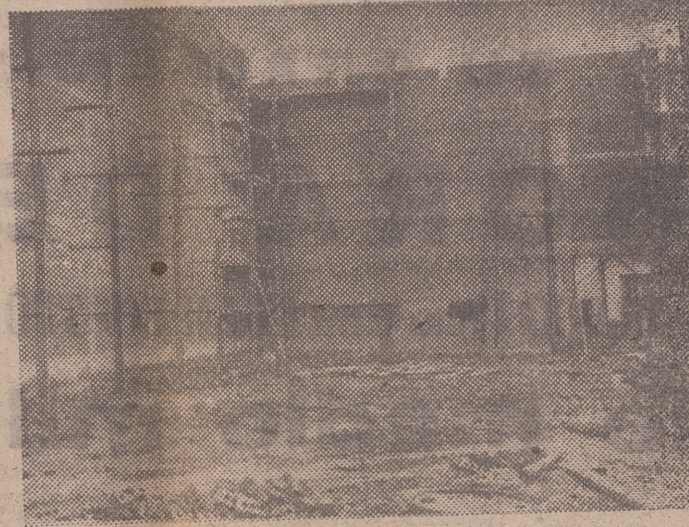
En la fotografía vemos el estado actual del frontón que la empresa Sevillas, S. A. está construyendo en Arnedo, y cuyas obras van a un ritmo acelerado.
