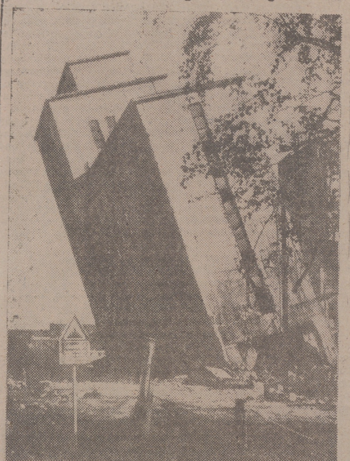
HAMBURGO. — Los obreros de la brigada especial de la fábrica de gas se dispusieron a volar este silo de carbón de cok, ya inservible. La primera carga hizo explosión, sin resultado alguno. Siguieron otras dos. Lo más que se consiguió fue que la torre se inclinara, pero de caerse, nada. (Foto Europa-Press).
