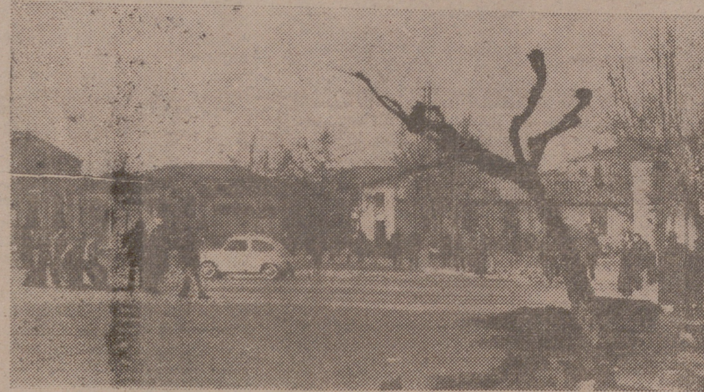
Continúan las obras de la nueva plaza circular que se está construyendo a la entrada de Marqués de Murrieta. Ahora le ha tocado el turno a la renovación del arbolado. Un bonito entretenimiento para los curiosos callejeros. (F. Jusam)
