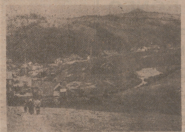
BRUSELAS. — Una vista general del escenario de la catástrofe, en el que puede verse perfectamente el camino recorrido por los residuos. Al fondo, la rue de Fleron, parcialmente cubierta por la avalancha. Grúas, tractores y "bulldozers" trabajan en el descombro. (Foto Europa-Press)
