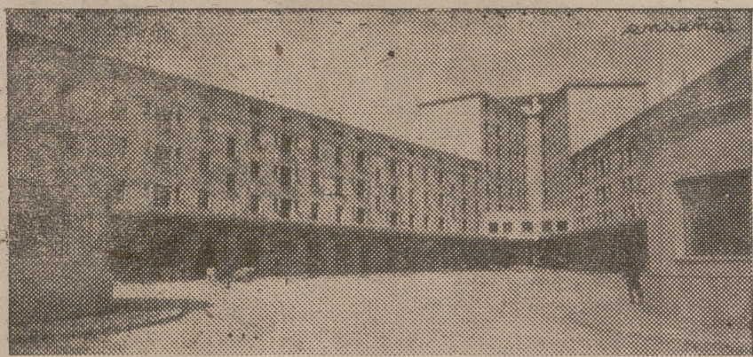
El patio interior de la Estación de Autobuses, visto desde la amplia entrada de vehículos.
