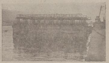
LAS PALMAS. --- En este puerto se termina la construcción de estos cajones que, debidamente remolca-dos y transportados por vía marítima, servirán para la construcción del islote artificial que va a estableerse frente a Sidi Ifni. Este islote se comunicará con tierra por transbordador, según está proyectado, dotándose por tan ingenioso sistema-de un desembarcadero a Sidi Ifni, nómicos son los de mayor im- están satisfechos de compartir cuya costa no se presta con facilidad a la construcción de
