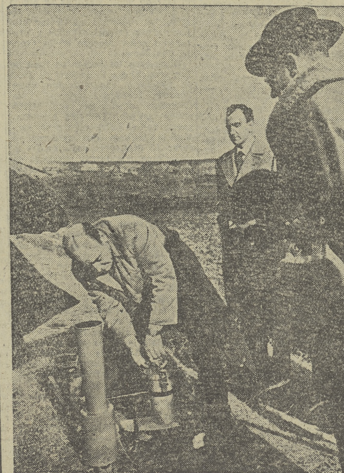
Un gerundés ha ideado el aparato espantapájaros mecánico que presenta el grabado. Consiste en un dispositivo giratorio que cañonea repartiendo explosiones mediante un tubo aplicado a uso de los extremos. Ha realizado recientemente demostraciones por estos campos.—Efe.
