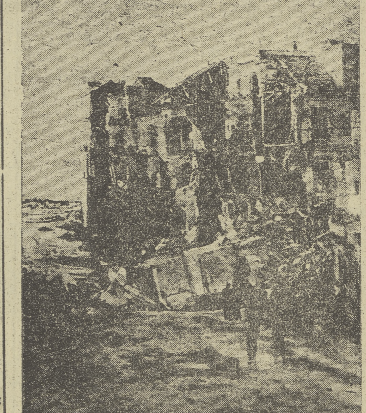
Un temporal de lluvias, con corrimientos de tierras e inundaciones, ocasiona hace unos días cientos de muertos en la zona de Salerno, en Italia. En nuestra fotografía pueden observarse los daños causados en una calle de Amalfi.
