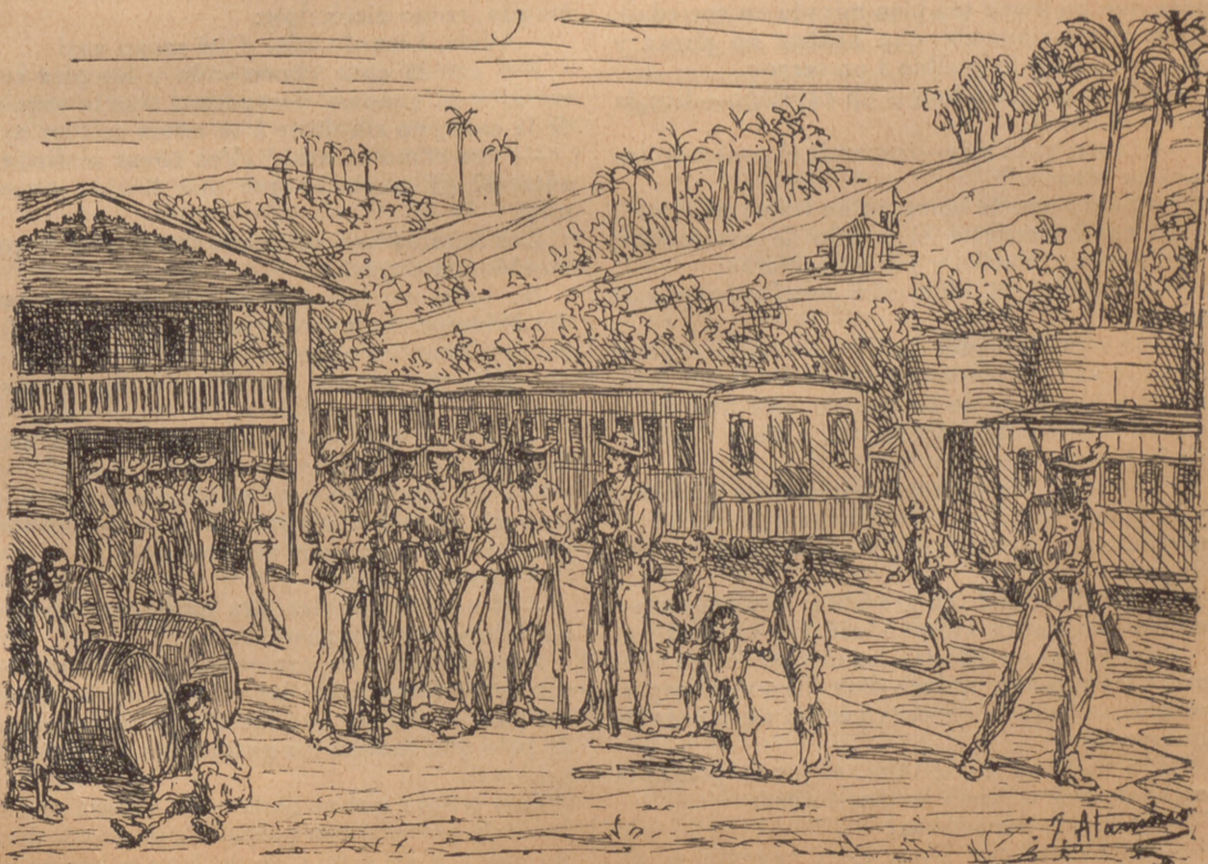
ESTACION DE SABANILLA
