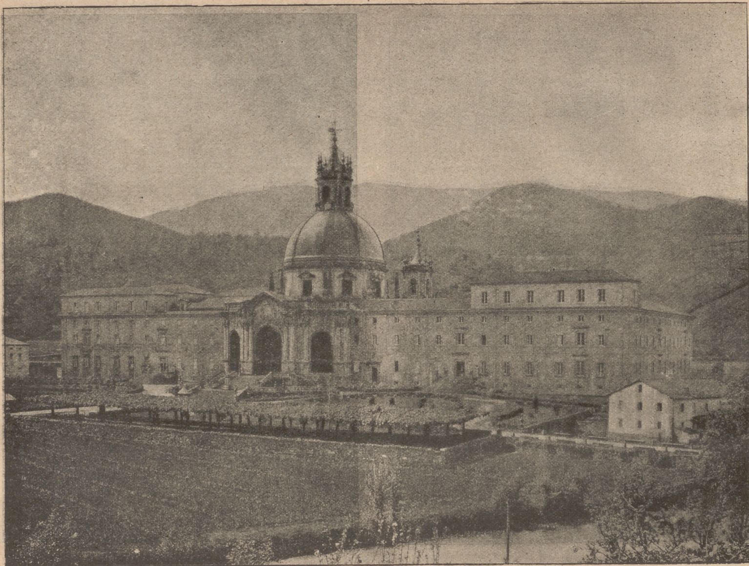
VISTA GENERAL DEL COLEGIO
