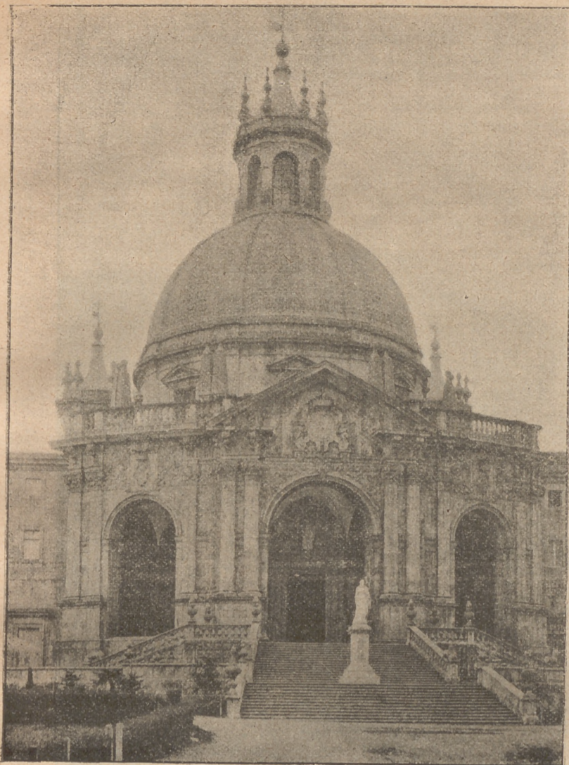
DETALLE DE LA FACHADA PRINCIPAL
