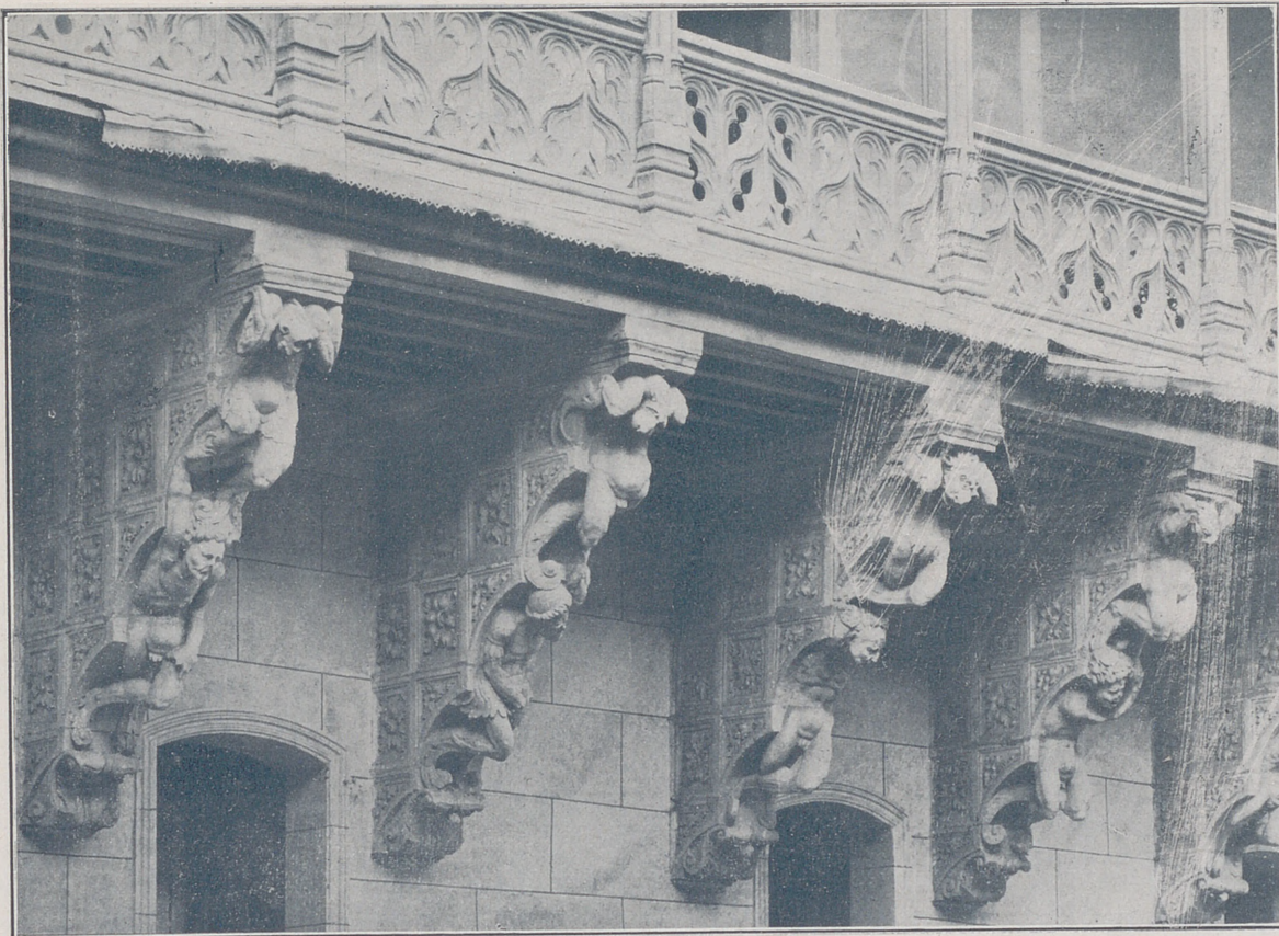
(Casa de la Salina). Un detalle de las valiosas ménsulas del patio.
