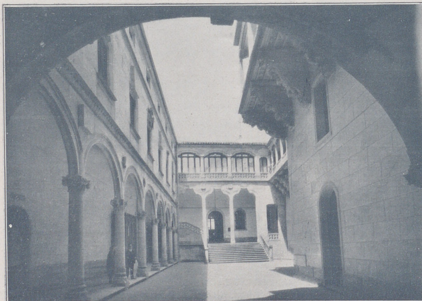
Vista general del patio.
