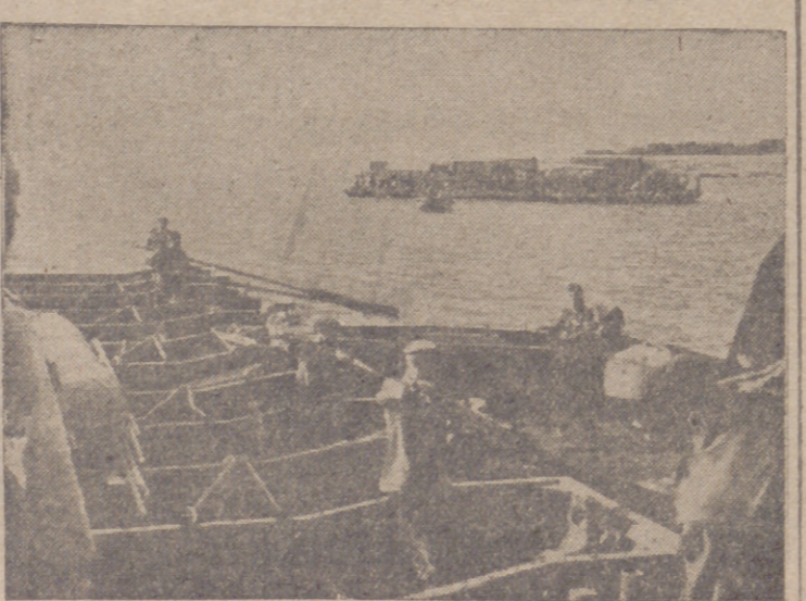
Unidades de ingenieros alemanes tendiendo un puente de barcas sobre un río
