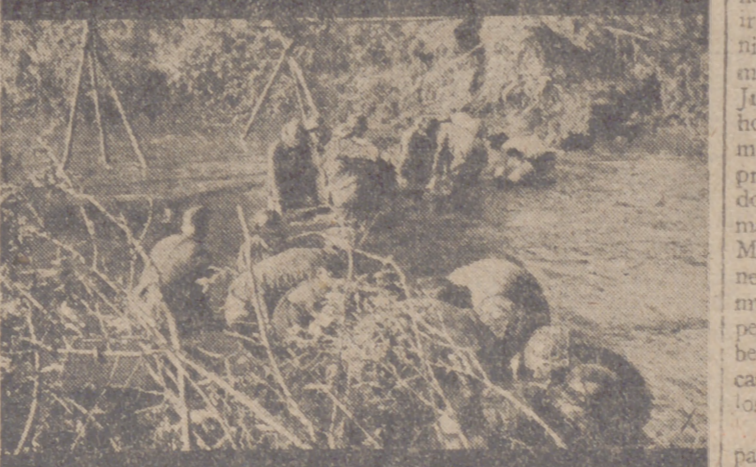
Zapadores alemanes preparan un lugar bajo las aguas de un río para poder hacer pasar los tanques alemanes
