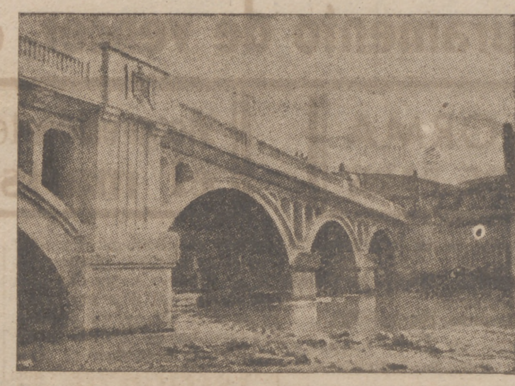
Detalle del puente del Caudillo sobre el río Ter, construido en 430 días
