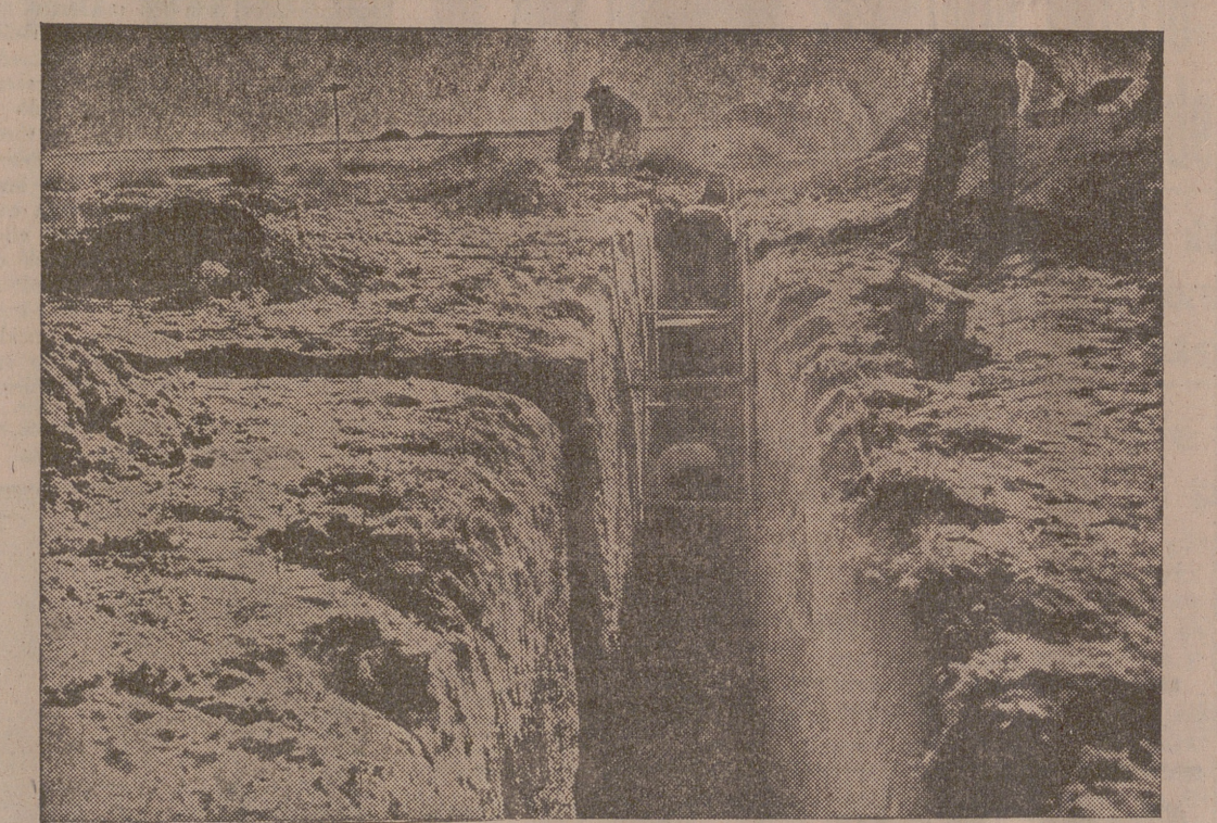
Sobre estas zanjas hondas se edificará en Mojados el primer Hogar Infantil de nueva planta (Foto Carbajal)
