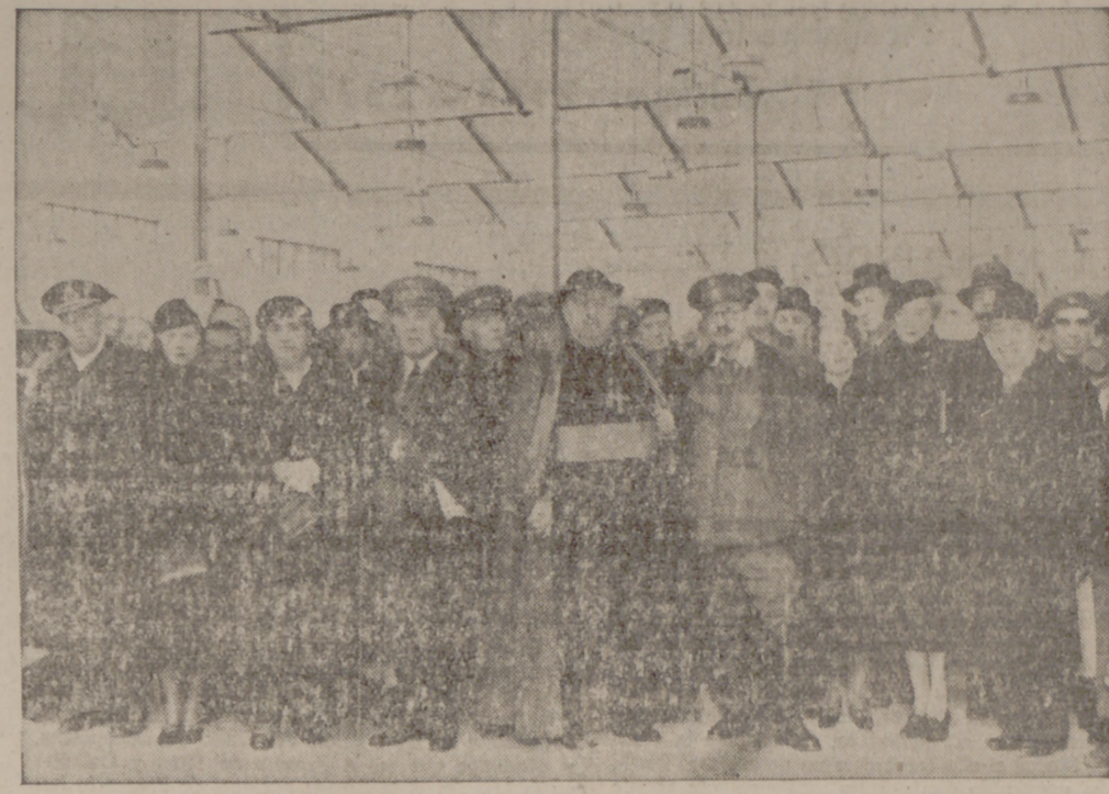
El Excmo. Sr. Obispo, general don Antonio Ferrer, gobernador civil y demás autoridades. Don Benito Leiva y familia, en el momento de la inauguración en la sala de máquinas
