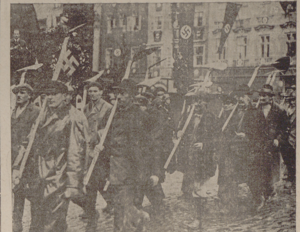
La construcción de nuevas autopistas en la comarca sudete. La foto muestra una columna de obreros que hasta ahora estaban sin trabajo que se dirige hacia el lugar de su nueva ocupación
