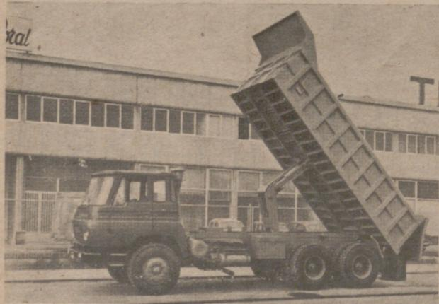
Camión Barreiros 64/26 V, provisto de basculante, dotado de cilindro estabilizador, de patente propia para 30 Tns. de potencia de elevación y caja "DUMPER" con puerta, especial para trabajos de cantera. Capacidad 12 metros cúbicos.
