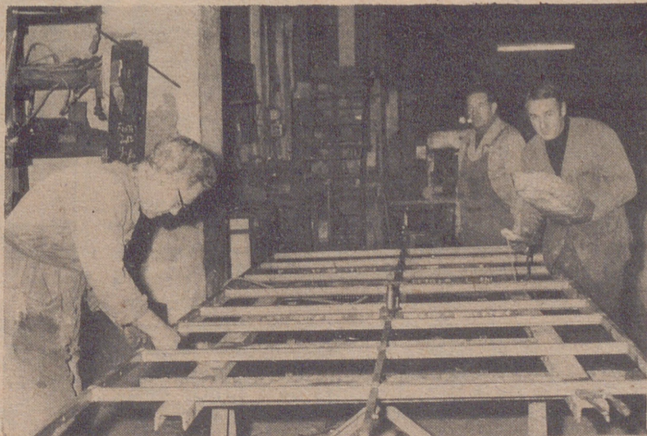
Para dar la vuelta a esta estructura metálica es preciso sacarla a la calle
