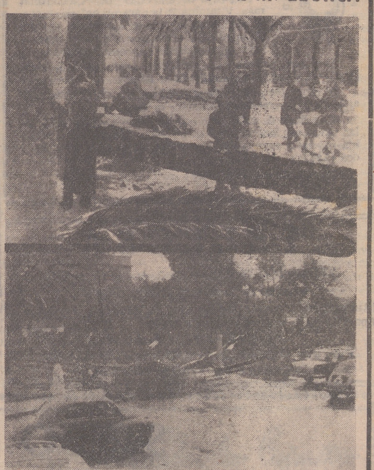
PALMA DE MALLORCA. — Un ciclón que ha durado cinco horas ha destruido miles de árboles, tejados y edificios en toda la isla, sin que, afortunadamente, haya que lamentar desgracias personales. Han sido especialmente afectados el pinar de Bellwar y los Paseos Marítimo y Sagrera.
