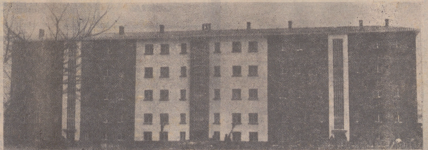
Aspecto del bloque de veinticuatro viviendas construido por Cáritas Diocesana de Logroño e inaugurado ayer, domingo, juntamente con la Parroquia de San Pío X, una guardería infantil, academia nocturna y residencia para religiosas, instaladas en las plantas bajas del mismo. — (Foto Jusam).
