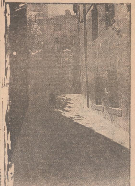
El pavimento de adoquines está muy bien para el tránsito rodado. Pero ese pavimento, sobre todo si está destrozado y en tan malas condiciones como el de esta Travesía del Labrel, en su salida a los Muros de Bretón de los Herreros y Once de Junio, no es precisamente la vía indicada para el tránsito que cabe en esa pequeña travesía, con su guardacantón en medio.
