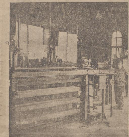
El vidrio sale, ininterrumpidamente, por cada una de las siete máquinas del horno, a velocidad variable, según espesor, desde 0'30 metros a 1'20 metros por minuto.
