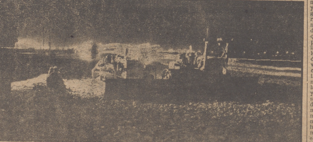
Día y noche trabajan los obreros en la construcción de un nuevo aeródromo en Berlín, enclavado en el sector francés, y que está a punto de quedar terminado. Con éste y los demás campos de aviación distribuidos por los sectores occidentales se trata de perfeccionar el abastecimiento aéreo de la capital alemana venciendo el bloqueo impuesto por Rusia. (Foto A. P.)
