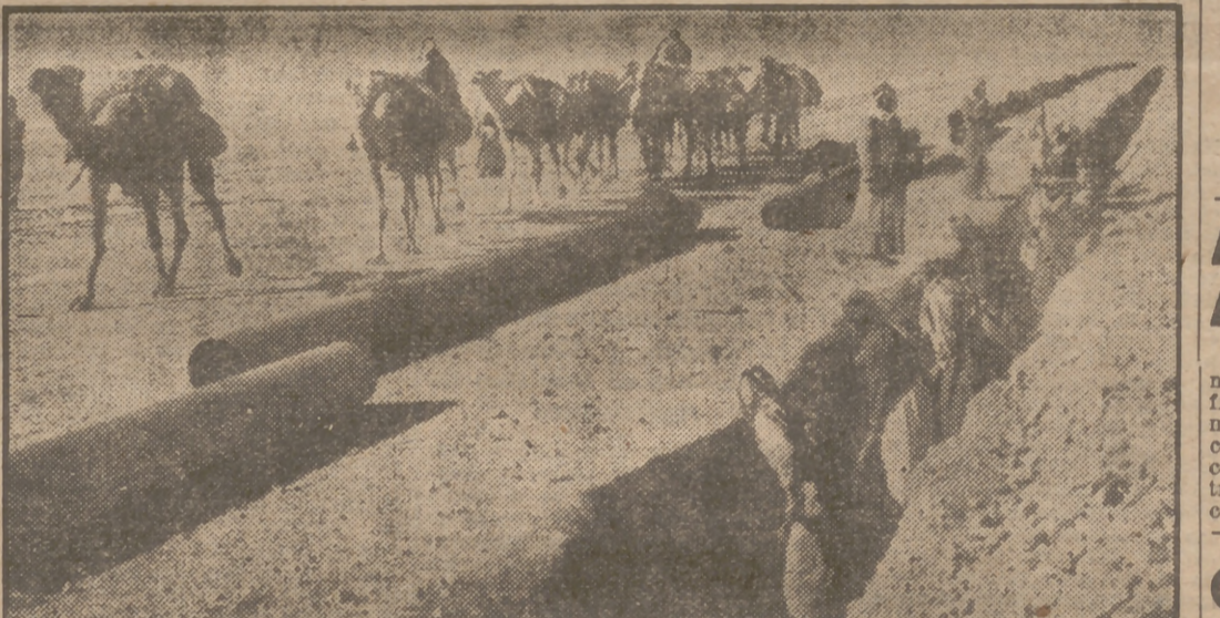
Una caravana de camellos pasa ante las zanjas destinadas a recibir las tuberías que unirán los centros productores de petróleo del Iraq con Bagdad. (Foto A. P.)
