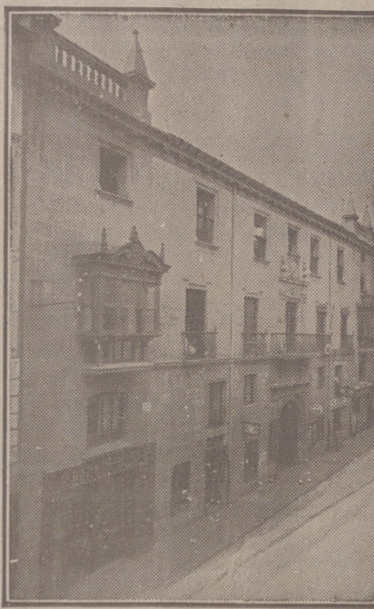
Fachada, por la calle de Santander, 10, 12 y 14, de la CASA SOCIAL propiedad de la Federación Burgalesa de Sindicatos Agrícolas Católicos.
