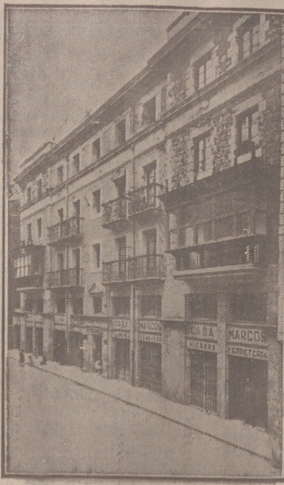
Fachada, por la calle de la Moneda, números 16 y 17, de la CASA SOCIAL propiedad de la Federación Burgalesa de Sindicatos Agrícolas Católicos.
