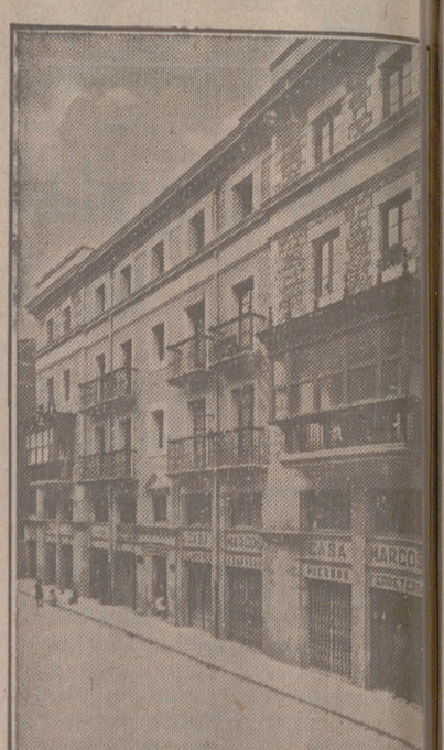
Fachada, por la calle de la Mo... números 15 y 17, de la CASA SOCIAL propiedad de la Federación Burgalesa de Sindicatos Agrícolas Católicos
