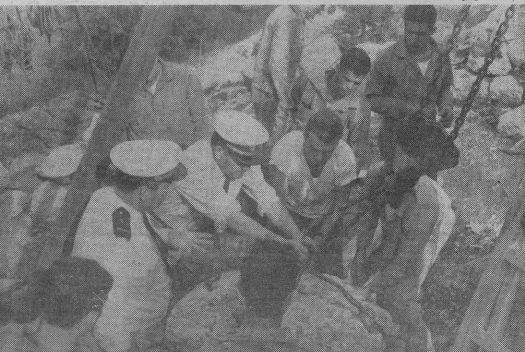
BAJO EL MANDO DEL SEGUNDO COMANDANTE DE LA ESTACION NAVAL DE SOLLER DON LUIS ANTONIO CORRAL Y LA DIRECCION DEL CONTRAMAESTRE MAYOR DE LA ARMADA, D. FERNANDO BONACHERA VAZQUEZ, SE HA COMENZADO LA RECONSTRUCCION DE LAS COLUMNAS. EL SUBTENDIENTE CONTRAMAESTRE, D. NICOLAS ERIAS REY, UN EQUIPO DE MARINEROS SE DISPONE A IZAR UNA DE LAS ENORMES PIEDRAS —DOS TONELADAS Y MEDIA DE PESO—, DE UNA DE LAS COLUMNAS PROTOHISTORICAS.
