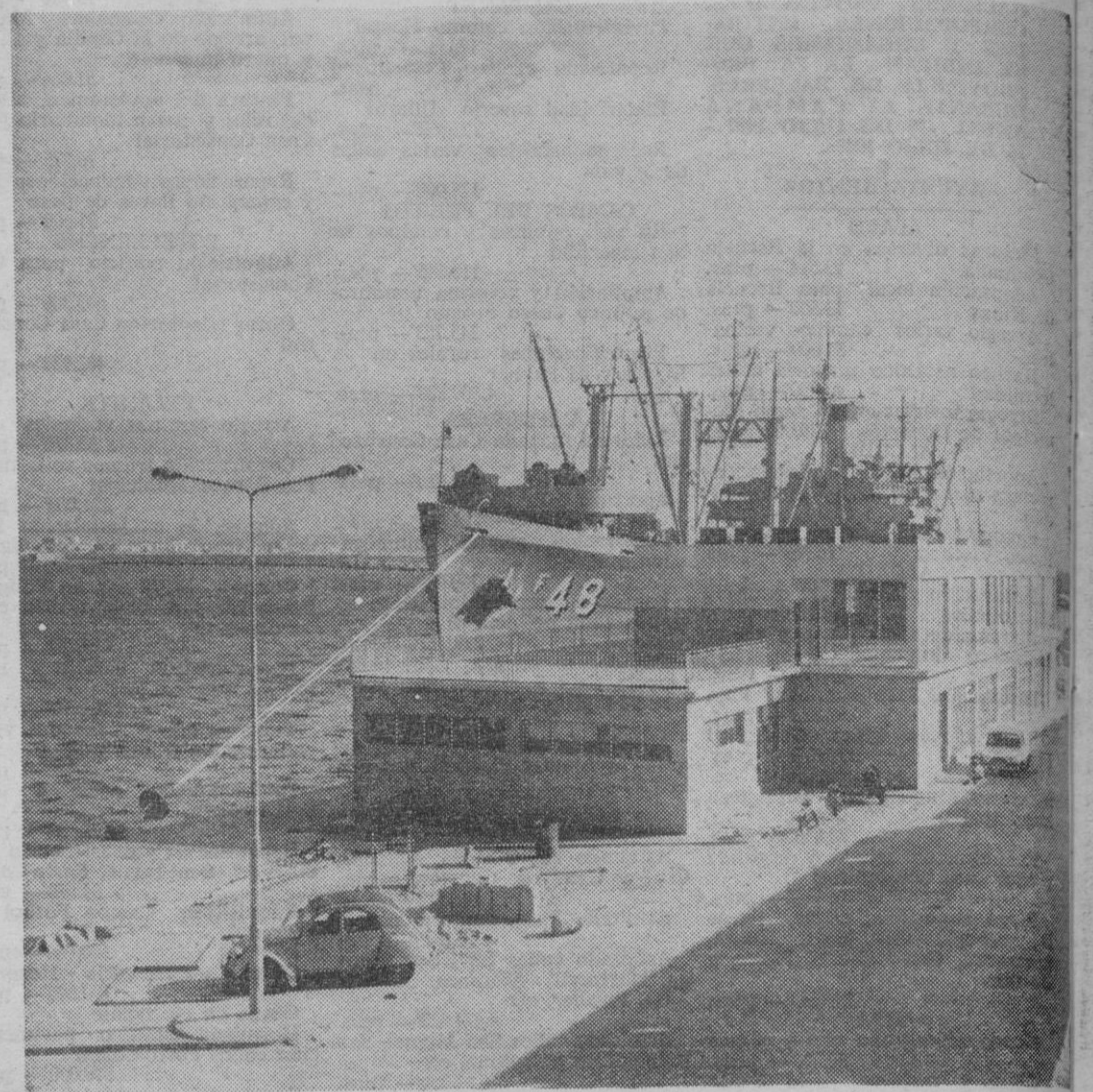
ESTACION MARITIMA DEL DIQUE DEL OESTE DE PALMA.
