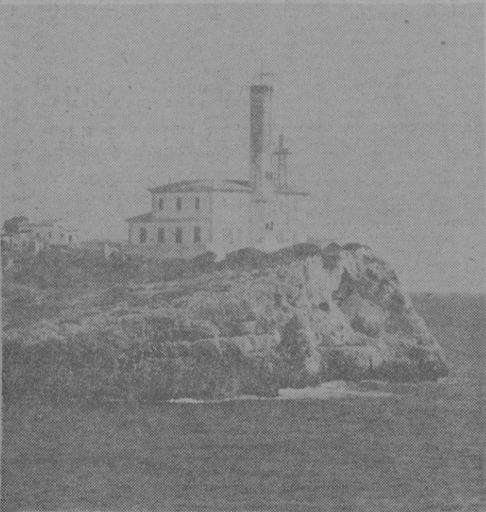
FARO ANTIGUO, VIGIA EN EL MAR, DE PORTO COLOM. AHORA LO ESTÁN MODERNIZANDO, REALIZÁNDOSE EN SU INTERIOR — Y EN LA PARTE EXTERIOR — OBRAS IMPORTANTES. LOS YATES VISITANTES, A SU ENTRADA EN EL TERMINO MARITIMO DE FELANITX, RECIBIRAN EL «SALUDO» DEL TÍPICO FARO.
