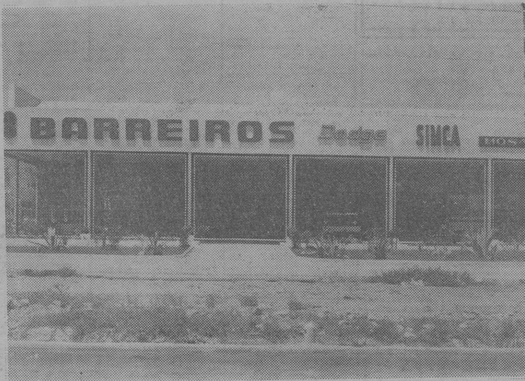
VISTA DE LA FACHADA PRINCIPAL DE LA BASE BARREIROS RECIEN INSTALADA EN LA CARRETERA DE INCA.
