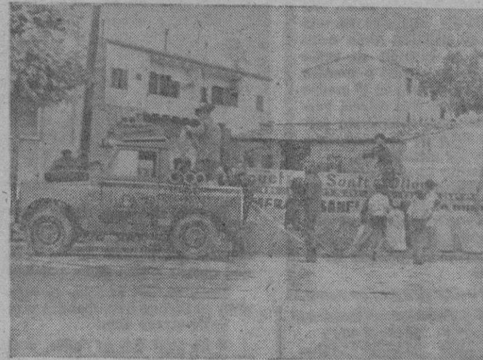
Un equipo de Bomberos, trabajando en el achique de los hoyos que se inundaron en el solar del futuro «Palacio de la Prensa». (Foto "Juanet".)
