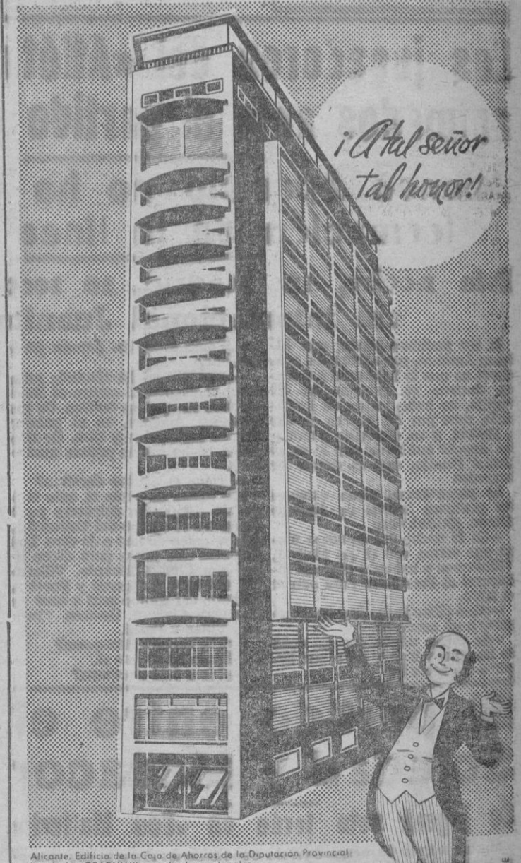
Alicante: Edificio de la Caja de Ahorros de la Diputación Provincial. Instalación GRADULUX en todos los ventanales.
