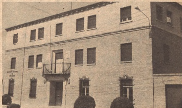
Un ejemplo de lo que no debe ser, lo tenemos en este magnífico edificio que pudiendo albergar un centro quirúrgico de importancia media, sirve solamente, para acoger las oficinas de I.N.P. y para que pasen sus consultas los médicos de la Seguridad Social.
