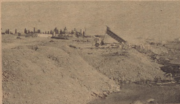
La foto da idea del costoso movimiento de tierras que se está haciendo para desecar la balsa
