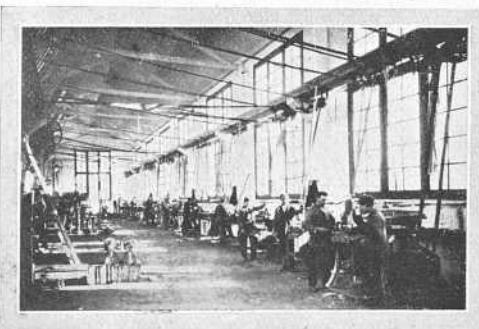
Otro aspecto de la sala de máquinas.
