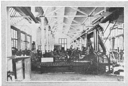
Sala de maquinaria.
