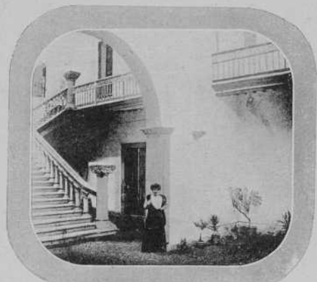
El Hall (en construcción).
