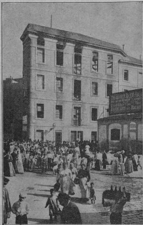
Vista exterior del edifici incendiat.
