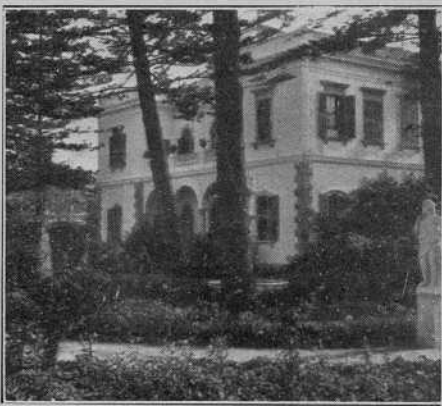
Vista de la Casa Consistorial de La Línea de la Concepción
