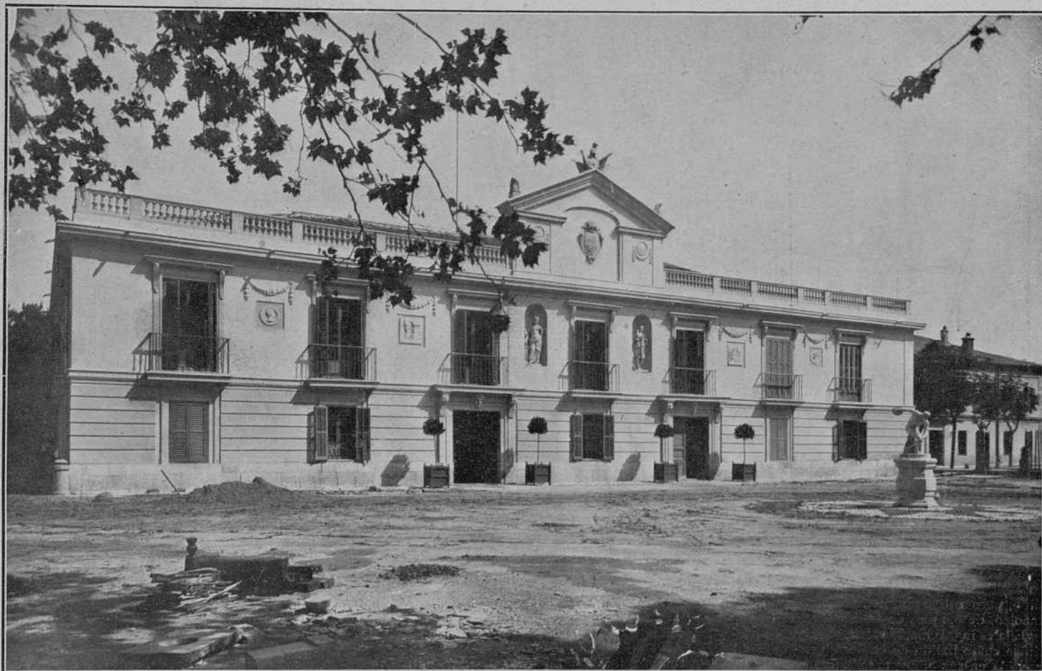
Fachada principal, restaurada, del Palacete de la Moncloa
