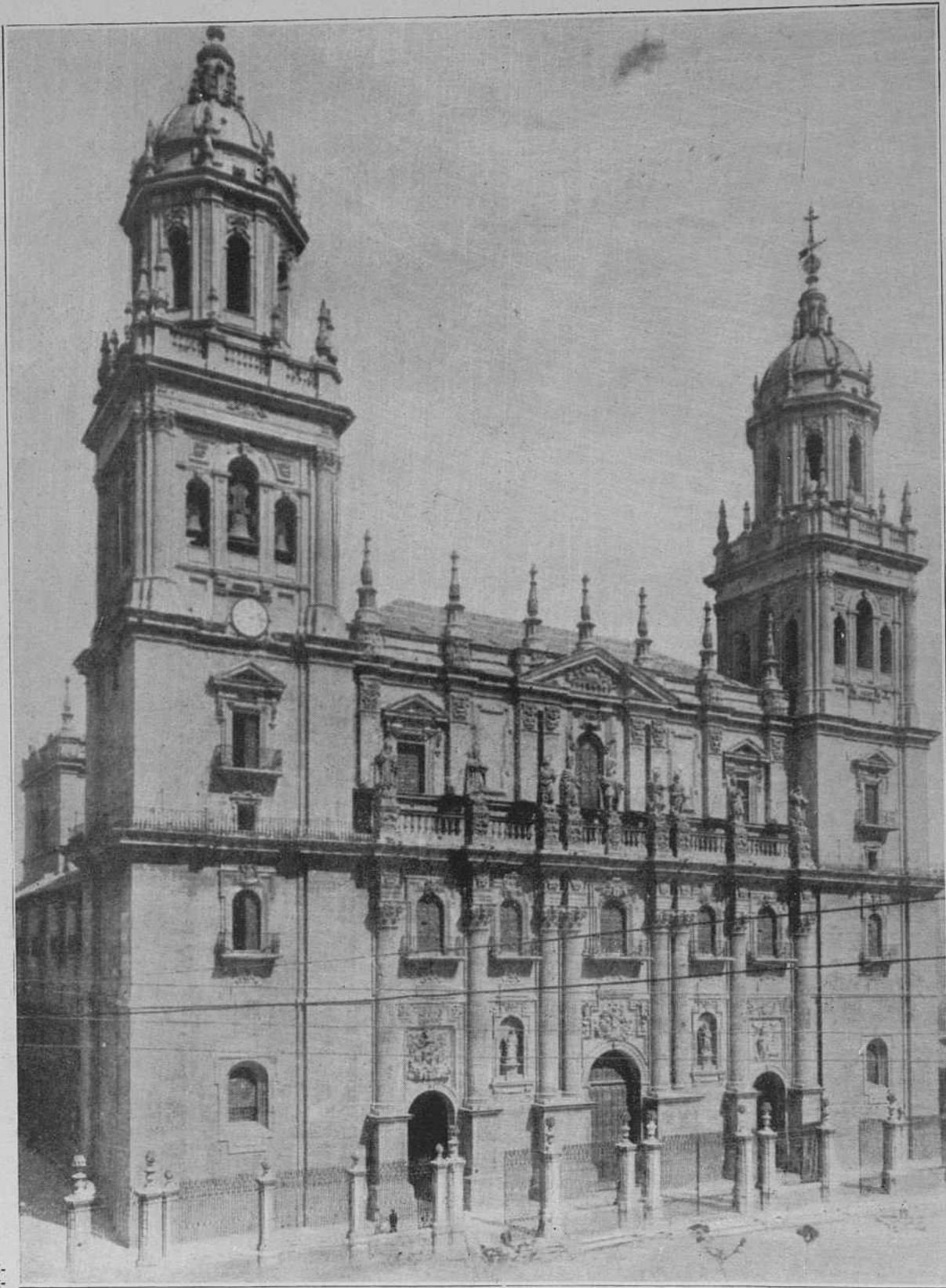
Fachada principal de la mag-
