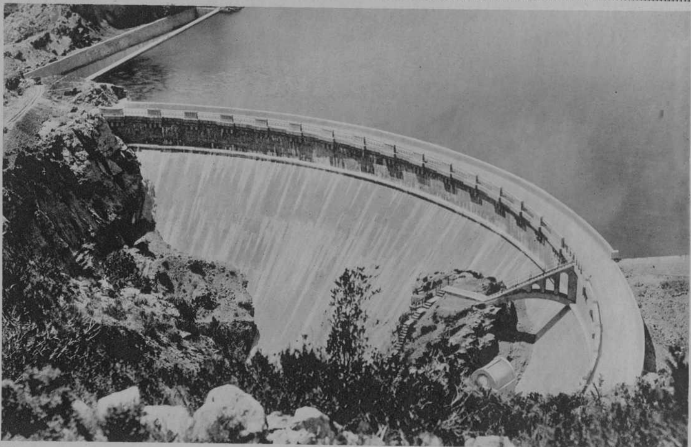
Muro de contención del pantano de Chera y canal de desagüe (Fots. Rodríguez)
