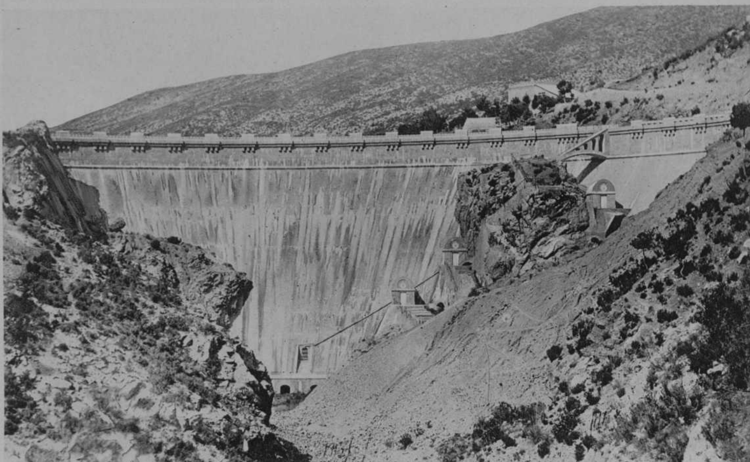
Muro de contención del pantano de Chera, que riega un gran número de hectáreas en la provincia de Valencia
