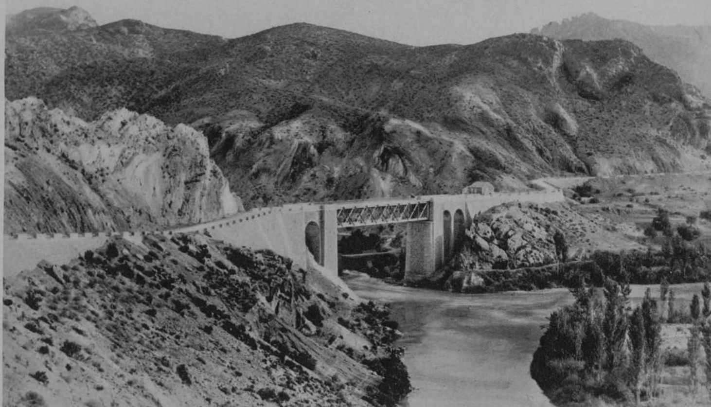
Puente en la carretera de Cofrentes, sobre el río Cabriel, en su confluencia con el Júcar
