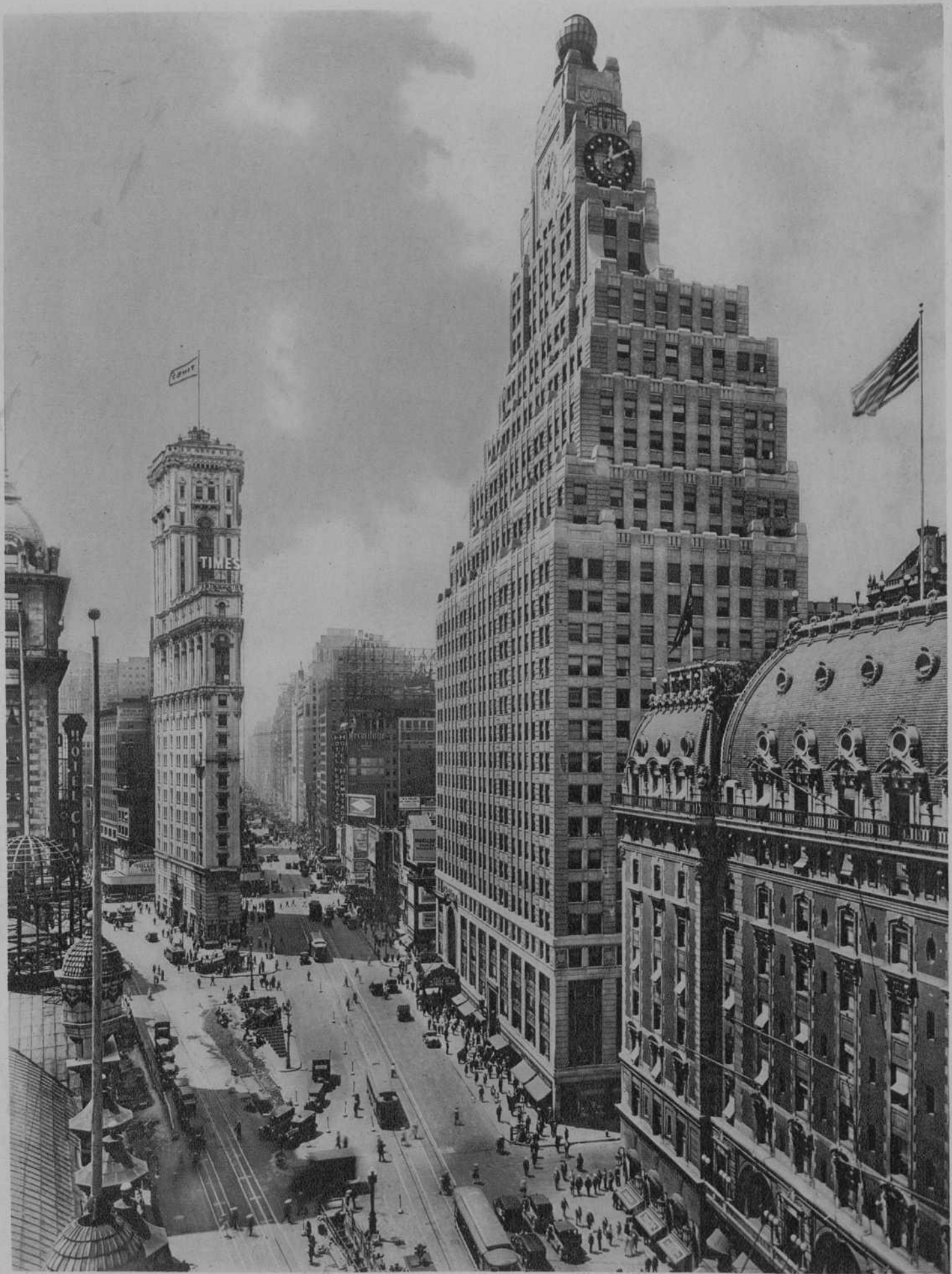
La «Times Square», una de las plazas más típicas de la urbe populosa. A la derecha, el gigantesco edificio de la Paramount. En el centro, la afilada construcción del diario «The Times» (Fot. Ortiz)
